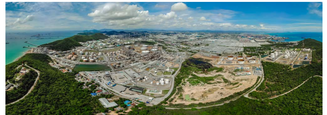
Insellösungen waren gestern! Eine integrierte Plattform vereinfacht die Zusammenarbeit auf der Baustelle und in den Backoffices.
